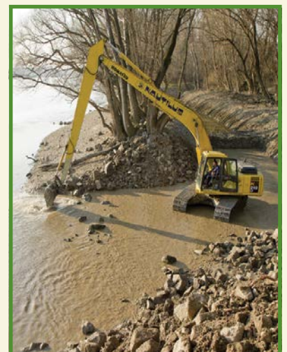
Obnova vtokovej časti Devínskeho ramena
