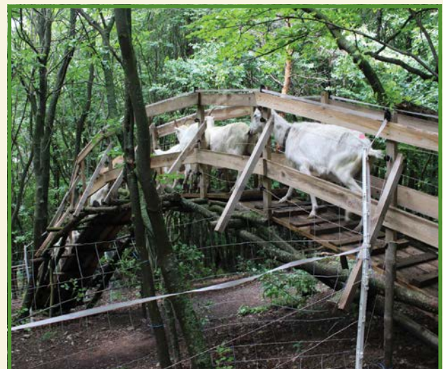
Originálne technické riešenia projektu – križovanie turistického chodníka
